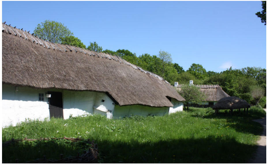
Et stråtag kan blødt og organisk følge efter gamle bygningers skævheder, indhak og udskud o.s.v. Mange stråtage sammen udgør et yderligere smukt syn, som her på Frilandsmuseet.
