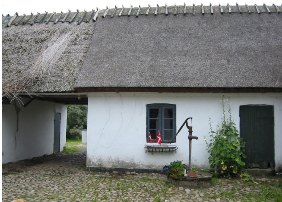
På kæppetækkede, bundne tage – det slidte stråtag til venstre - vil kæppene blive mere eller mindre synlige allerede 3-10 år, inden det skal udskiftes. Hvis kæppene er bundne med galvaniserede jerntråd, vil de kunne holde en del år, indtil kæppene rådner
